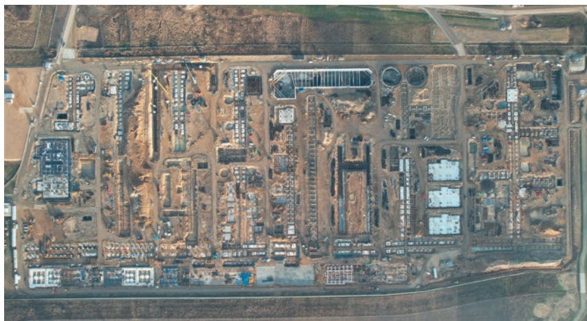
Rys. 5. Widok placu budowy (ISBL)
