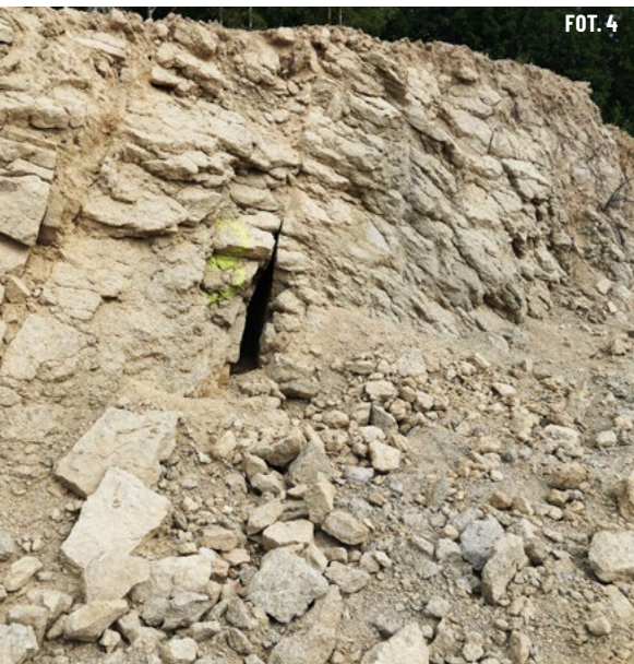
FOT. 4. | Płytko występująca pionowa szczelina o szerokości ok. 15 cm/ Fot. Keller Polska FOT. 5. | Strefa uskokuwa – druzgot piaskowcowy/ Fot. Keller Polska
