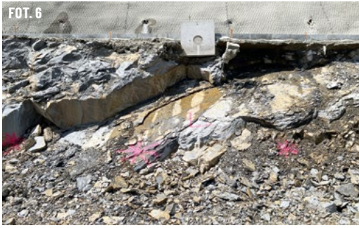
FOT. 6. | Grubopłytowe/blokowe odspojenie warstwy gruboławicowego piaskowca. Widoczna znacznych rozmiarów płaszczyna odkucia na bardzo cienkim przewarstwieniu zapiaszczonych łupków/ Fot. Keller Polska
