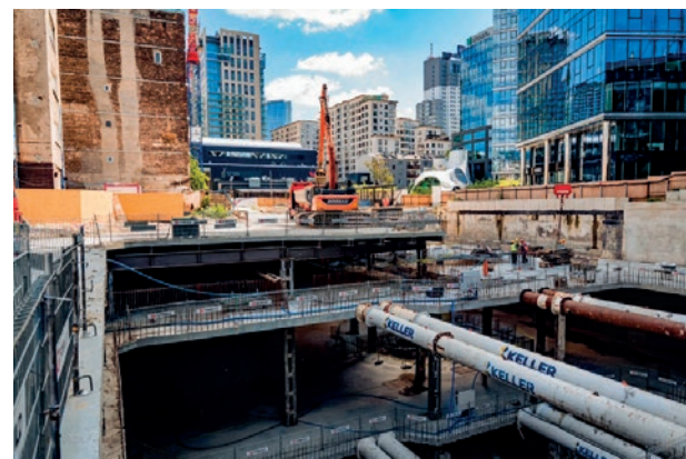
Pracująca palownica do pali VDW (powyżej) i dodatkowa, tymczasowa platforma stalowa (poziom 0) (poniżej)
