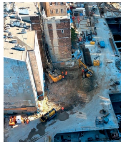
Pracująca palownica do pali VDW (powyżej) i dodatkowa, tymczasowa platforma stalowa (poziom 0) (poniżej)
