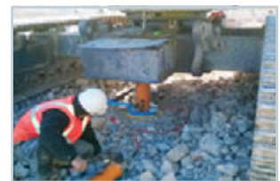
Próbnе obciążenia statyczne
